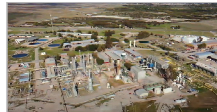
Central de Co-Generación Ecoenergía
