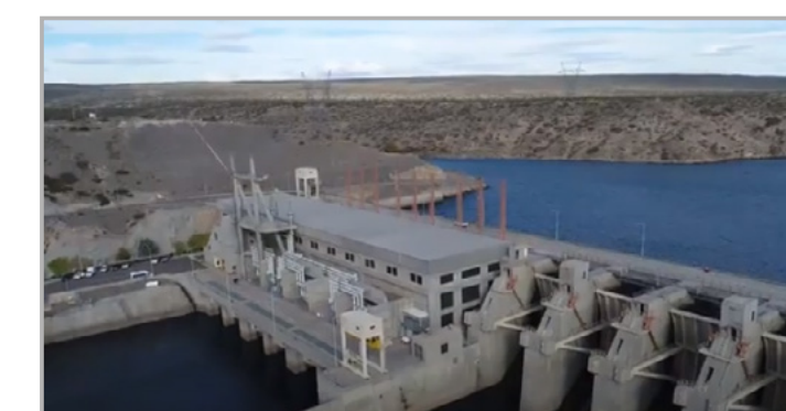
Hidroeléctrica Pichi Picun Leufú
