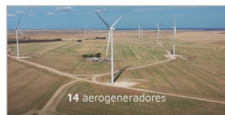
Parque Eólico Pampa Energía III
